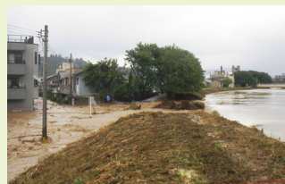
足羽川堤防（福井豪雨）
