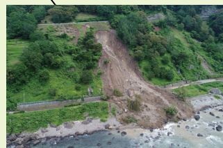
国道305号 (平成30年7月)
